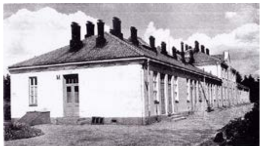
Paviljong ved Ullevål som hadde 23 isolater, alle med egen inngang og egen ventilasjonspipe
